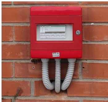
Figura 6: Cassetta di sezionamento VVF
